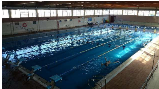
Il·lustració 33. Piscina coberta. Font: Servei Municipal d'Esports.
