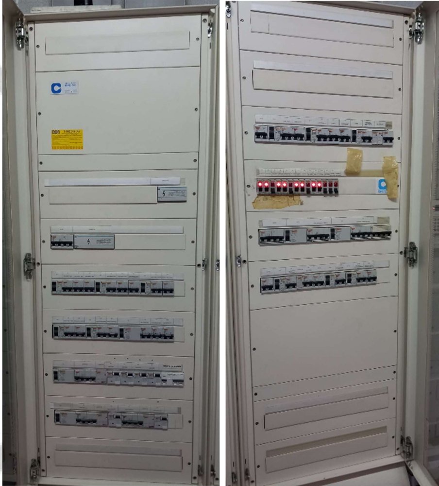
Quadre general de l'edifici on s'hi posaran les proteccions del nou clima
