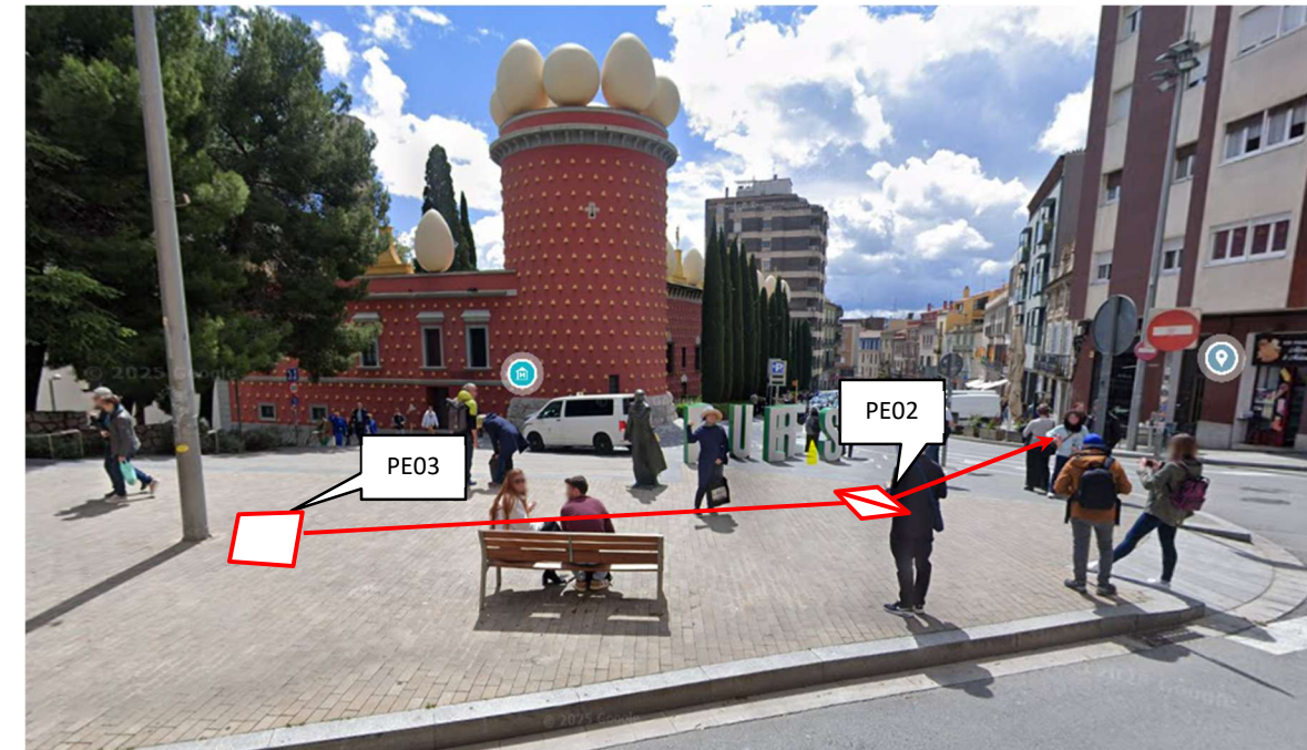
Il·lustració 40: Nova canalització tritub entre el nou pericó PE02 i el nou pericó PE03
