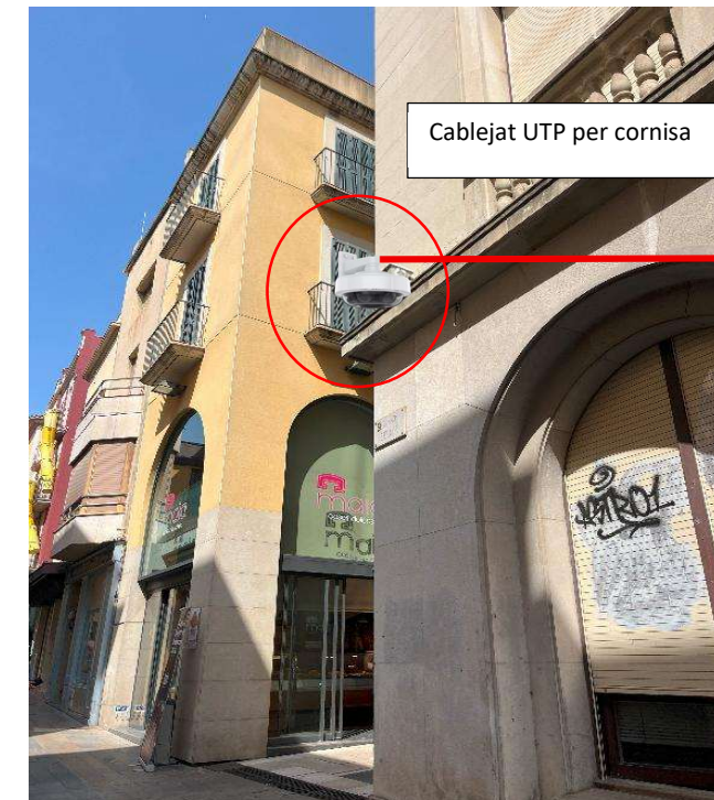
Il·lustració 57: Recorregut cable parells trenat PdC-07
