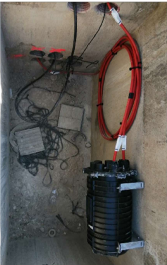
Il·lustració 5.1: Caixa d'empuïament tipus FIST
