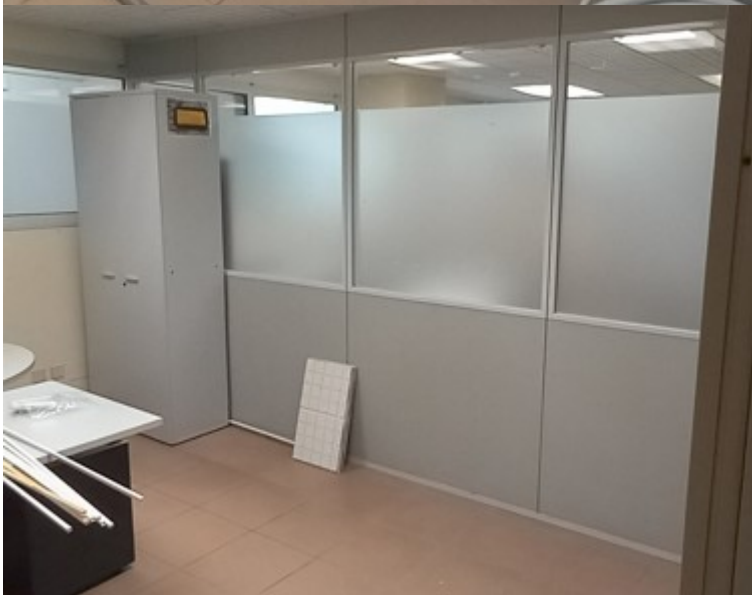
Foto 1. Envans d'alumini desmuntables a retirar
