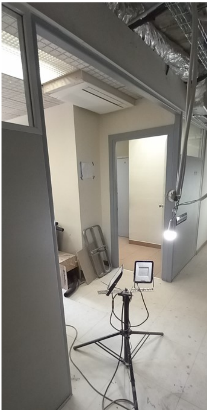
Foto 2. Buit d'obra on hi anirà col·locada la porta de vidrea amb dos fixos laterals
