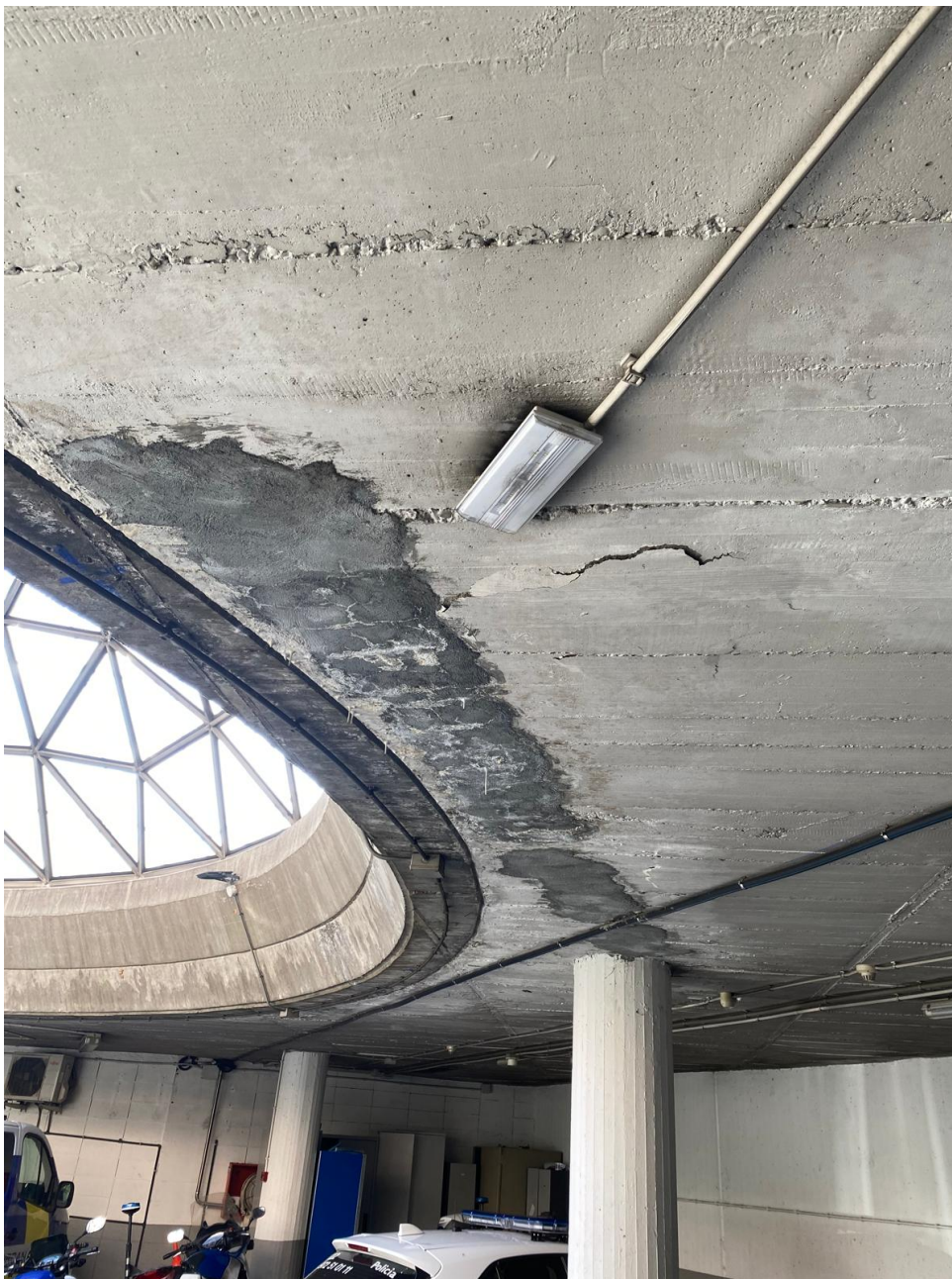
Foto 8. Detall forjat zona parking
