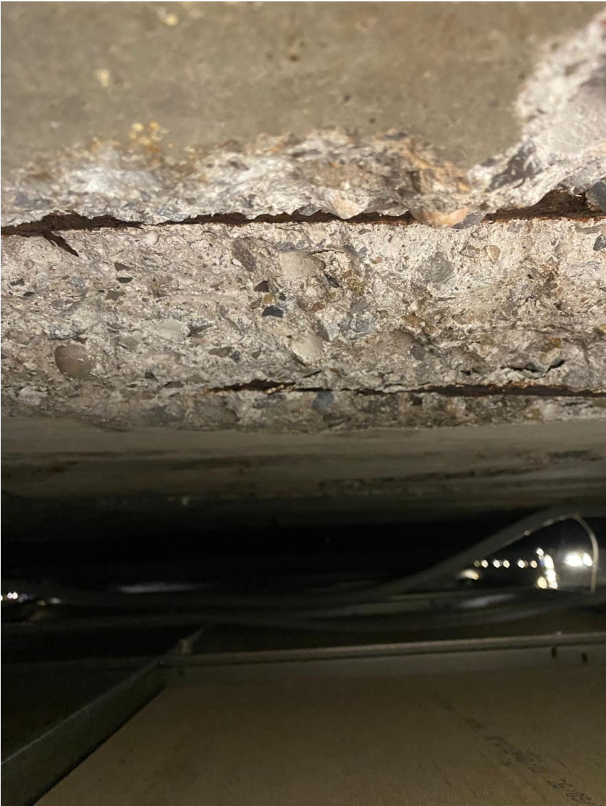
Foto 1. Detall forjat zona administració
