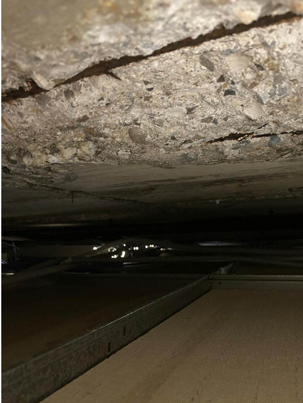
Foto 7. Detall forjat zona administració
