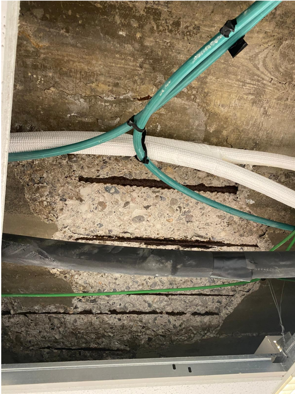
Foto 3. Detall forjat zona administració
