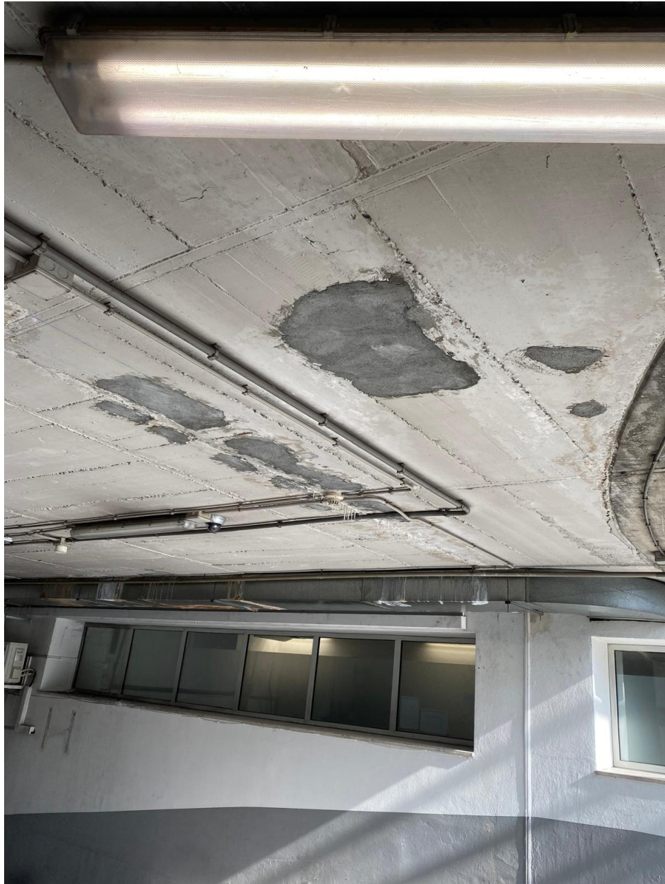
Foto 10. Detall forjat zona parking
