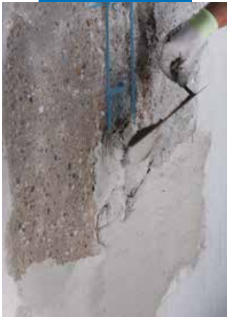
Aplicación con paleta de Planitop Rasa & Ripara
