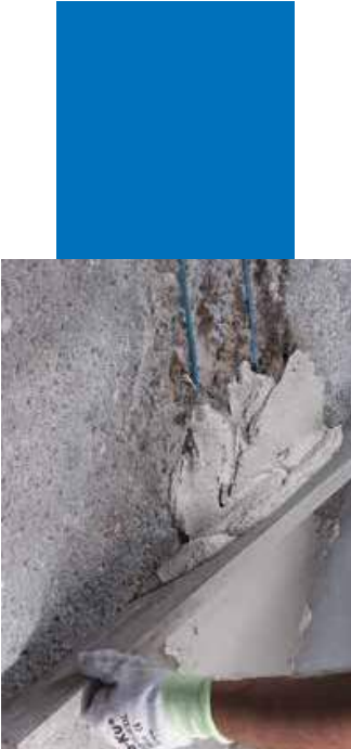
Regleado de Planitop Rasa & Ripara
