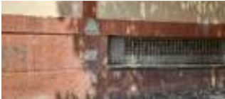
Mur P11 i Cèrcol P11, s'ha eliminat revestiment
