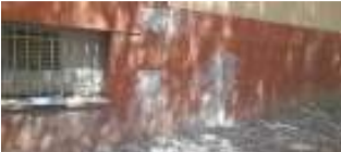
Mur P12 i Cèrcol P12, s'ha eliminat revestiment
