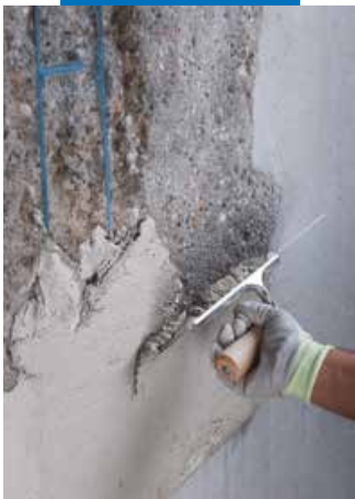
Aplicación con llana de Planitop Rasa & Ripara
