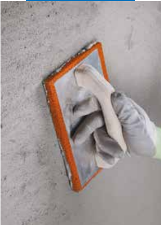
Fratasado de Planitop Rasa & Ripara
