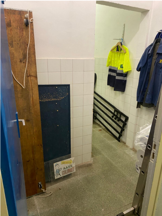
Foto 11. Vestíbul entrada lavabos Arts Escèniques
