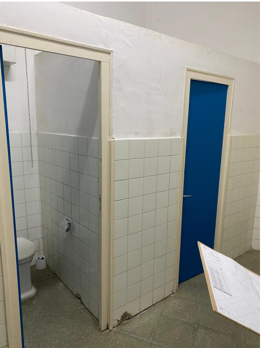
Foto 8. Lavabos a reformar de la part d'Arts Escèniques
