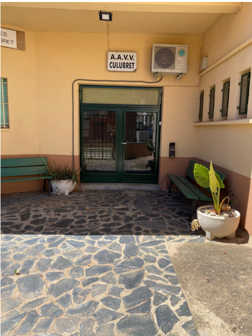
Foto 6. Entrada principal a modificar
