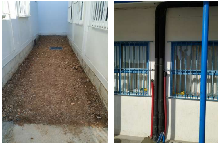
Imatge 8 i 9 .- Començament de la rasa R3 amb arqueta i acabament amb sortida de tub de reserva
