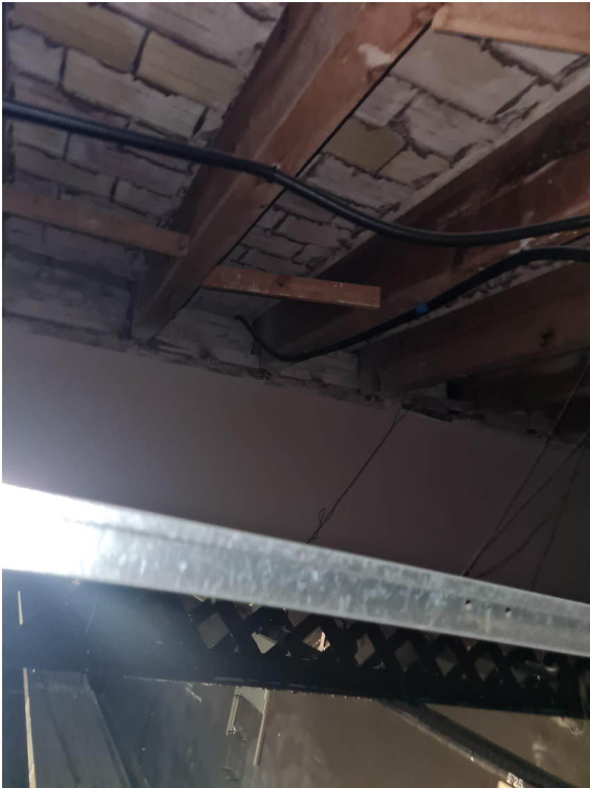
FOTOGRAFIA NÚM. 2 Vista inferior de la coberta on s'aprecia l'encadellat ceràmic que conforma la coberta, a sobre de les corretges de fusta.
