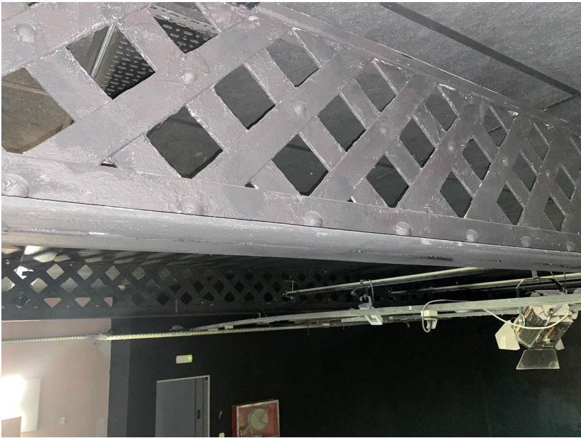
FOTOGRAFIA NÚM. 3 Vista inferior de la coberta on s'aprecia la gelosia metàl·lica que suporta les corretges de fusta.
