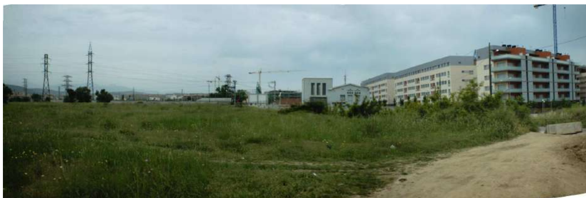
Els Olivars. Central hidroelèctrica i sector Fages de Climent
