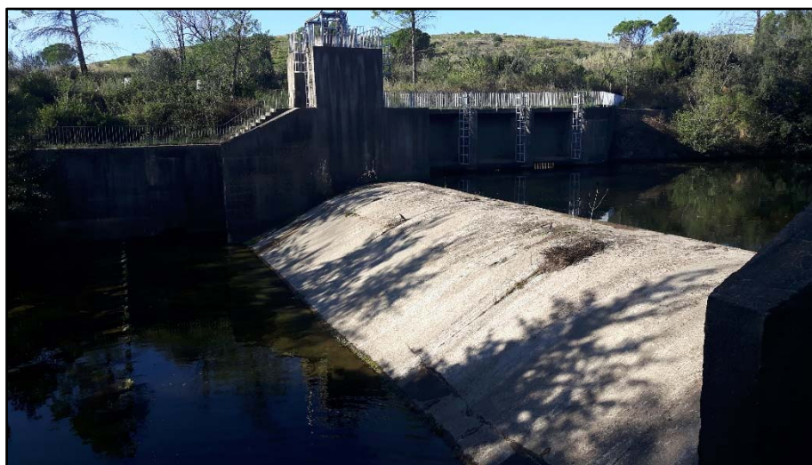
Imatge 2. Resclosa de Pont de Molins
