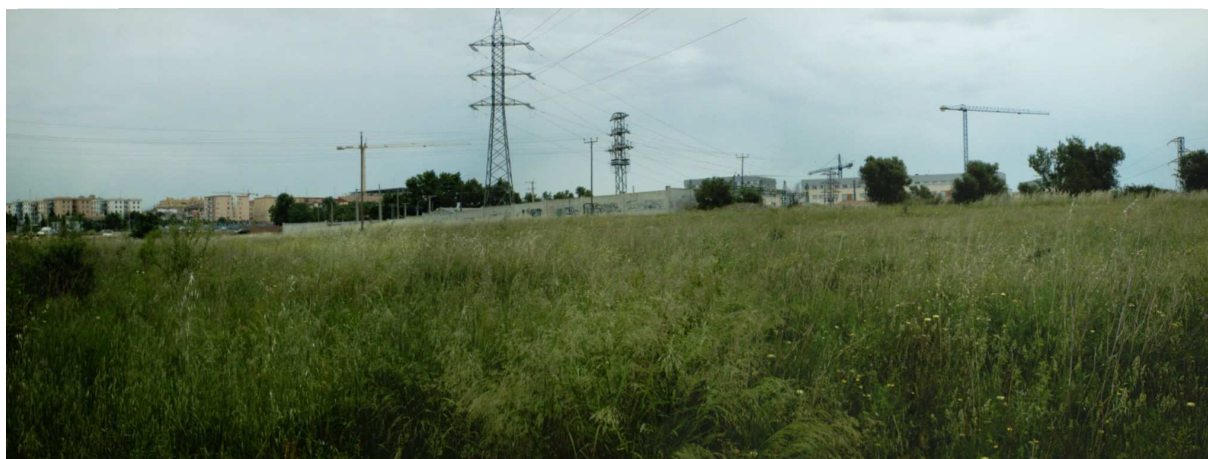
Zona verda vora el Rec Susanna. Al fons central hidroelèctrica
