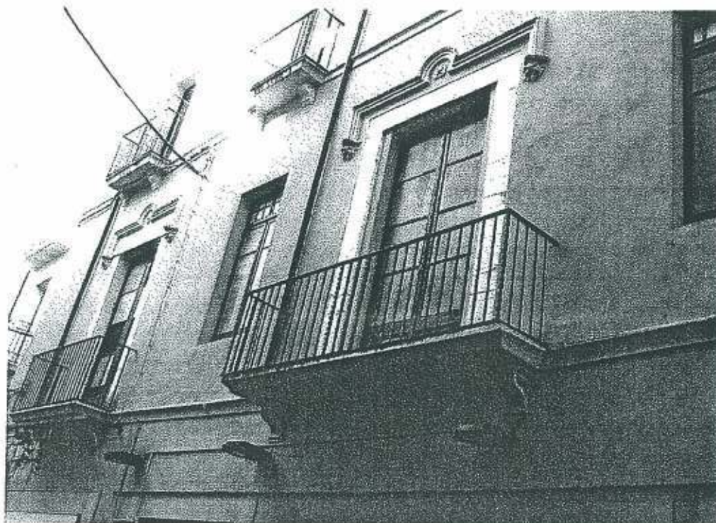
Resta de balcons de la façana de la casa Madern, amb el mateix marc de pedra, però sense cap estructura decorativa gòtica afegida
