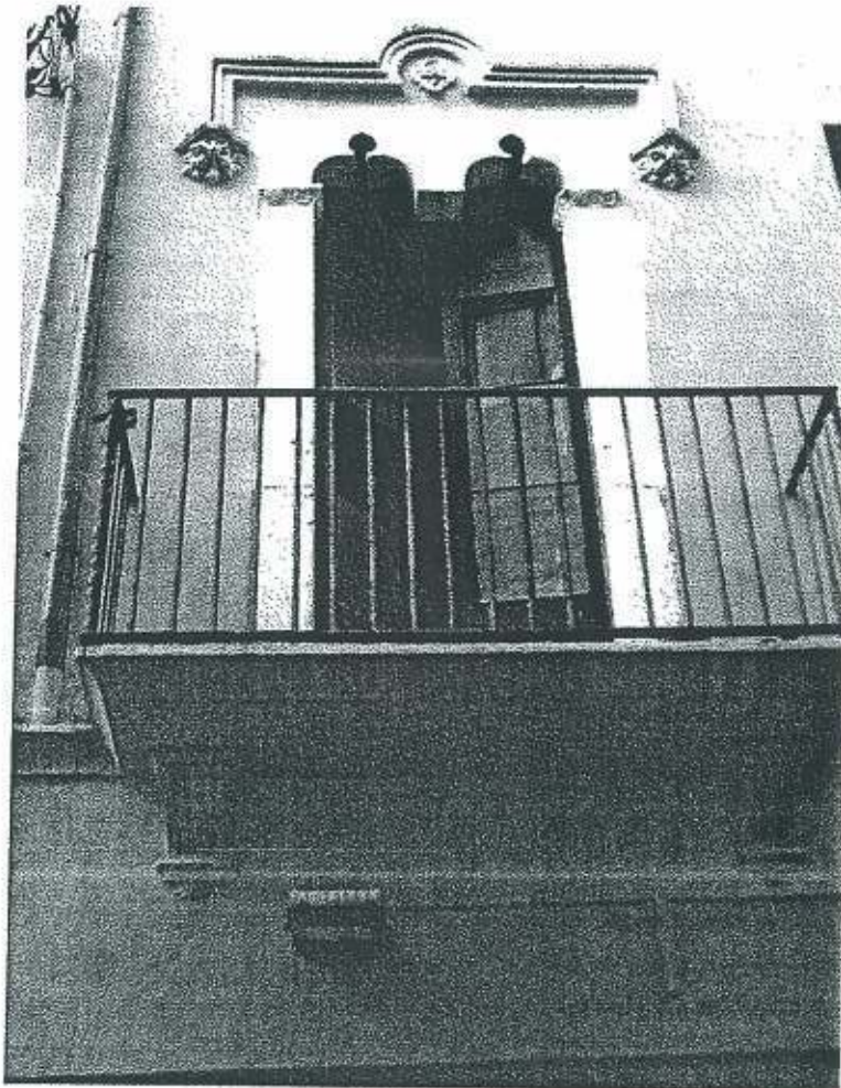
Vista general i detall del balcó amb elements de finestra coronella d'estil gòtic objecte del sondeig
