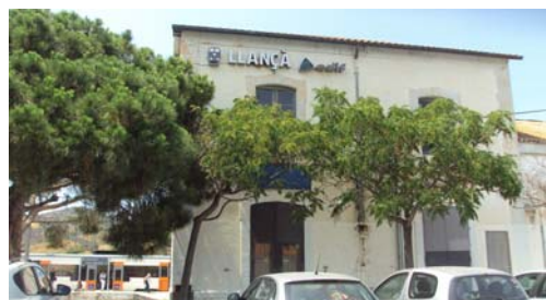
Estació de Llançà
