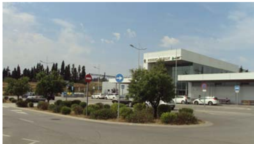
Estació de l'AVE a Vilafant
