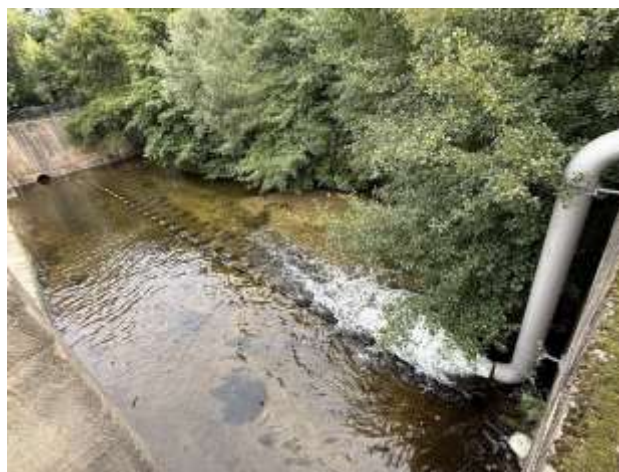
Aigua regenerada procedent de l'EDAR de Figueres retornada a la Muga a l'assut de Pont de Molins
