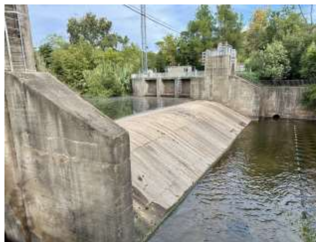
Assut de Pont de Molins. Separa les aigües de les comunitats de regants del marge dret i del marge esquerre de la Muga.
